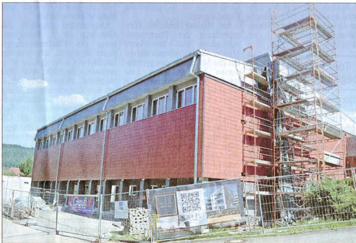
Die neue Fassade der Weisenbacher Sporthalle leuchtet in einem Rotton. Die Arbeiten schreiten voran. Foto: Gemeinde Weisenbach
